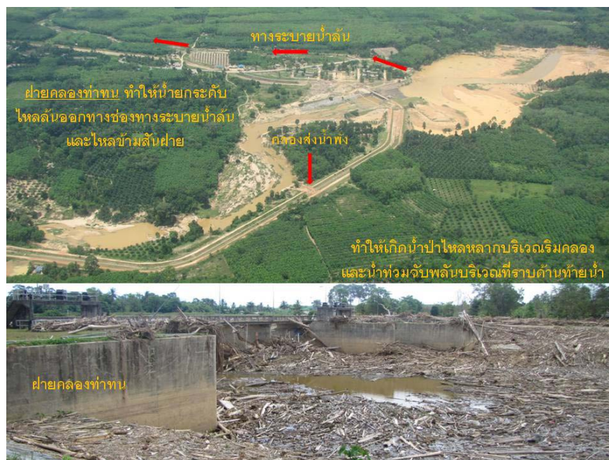
รูปที่ 5.2 ฝายคลองทำทอนที่สร้างกีดขวางทางน้ำ
