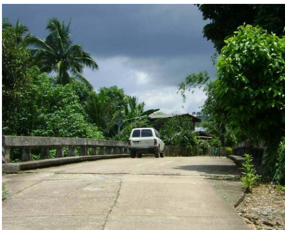
รูปที่ 3.13 บ้านเรือนที่ตั้งอยู่ใกล้ห้วยเฮี้ย บริเวณบ้านม่วงคำใต้ มีความเสี่ยงภัยน้ำป่าไหลหลากและดินถล่ม
