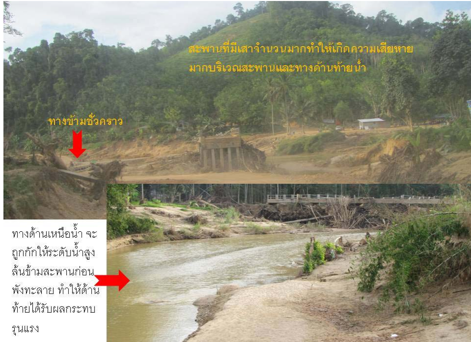
รูปที่ 5.3 สะพานข้ามลำน้ำซึ่งมีเสาสะพานจำนวนมาก กลายเป็นเขื่อนขนาดย่อมกีดขวางการไหลของเศษซากไม้และตะกอนดิน เมื่อไม่สามารถต้านทานไหวจึงพังทลาย
