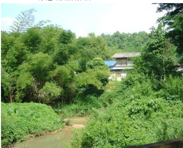
รูปที่ 3.4 บ้านเรือนที่ตั้งอยู่ใกล้ห้วยแม่พวกบริเวณบ้านน้ำแรม มีความเสี่ยงภัยน้ำป่าไหลหลาก
