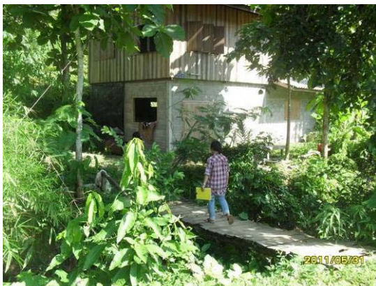
รูปที่ 3.23 บ้านเรือนที่ตั้งอยู่ใกล้ห้วยโป่งบริเวณ บ้านเค็มที่มีความเสี่ยงภัยน้ำป่าไหลหลาก
