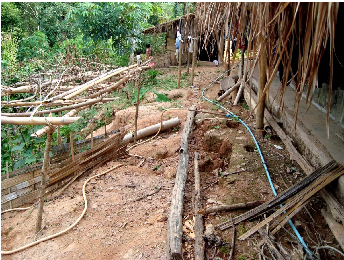
รูปที่ 3.29 ร่องรอยการทรุดตัวของดินจากการตั้งบ้านเรือนอยู่บริเวณไหล่เขาที่มีความลาดชันสูง บ้านห้วยโย
