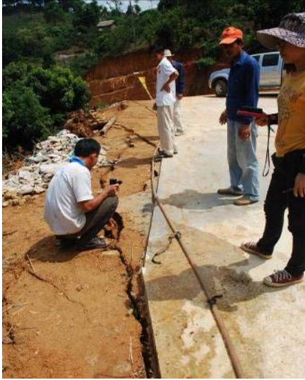
การถมดินเพื่อเพิ่มพื้นที่ในการก่อสร้าง
