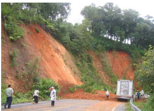
รอยดินไหลบนถนนทับเส้นทางสัญจร
