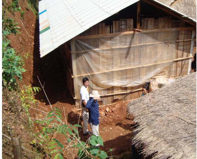
การตัดลาดดินเพื่อสร้างที่อยู่อาศัย
