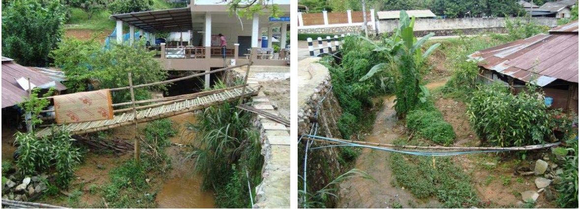
รูปที่ 3.16 พื้นที่เสี่ยงภัยจากน้ำท่วมฉับพลันบ้านห้วยไร่สามัคคี บ้านเรือนที่ตั้งอยู่ติดลำห้วยไร่และตั้งอยู่บริเวณสภห้วยมีความเสี่ยงสูงที่จะเกิดน้ำท่วม
