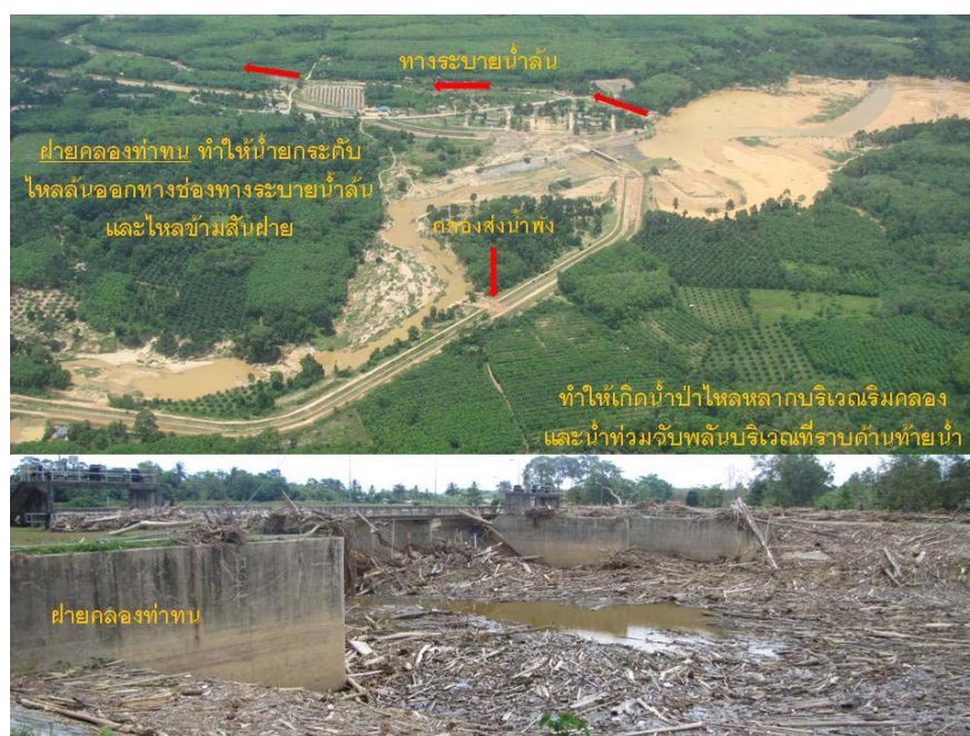
รูปที่ 5.2 ฝายคลองท่าหนที่สร้างกีดขวางทางน้ำ
