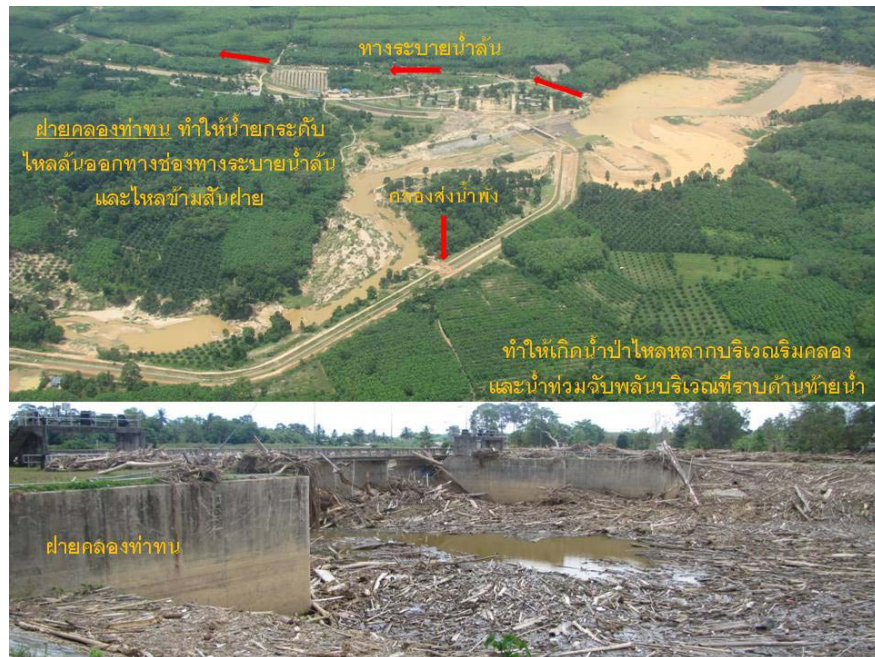
รูปที่ 5.2 ฝายคลองท่าทอนที่สร้างกีดขวางทางน้ำ
