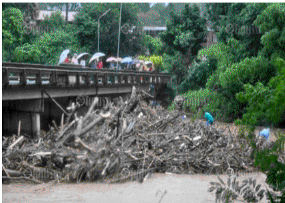
รูปที่ 2.6 ความเสียหายจากเหตุน้ำป่าไหลหลากในพื้นที่อำเภอเชียงคำ จังหวัดพะเยา
