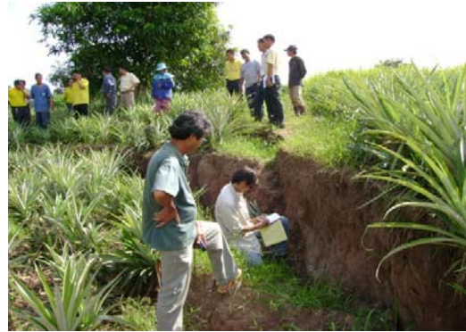
รูปที่ 2.5 พื้นดินมีการทรุดตัวลงต่ำกว่าระดับเดิมลึกประมาณ 1 เมตร
