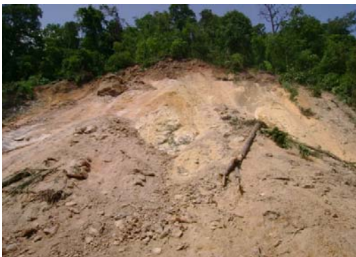
รูปที่ 2.2 ผนังปูนแตกออก แสดงให้เห็นถึงเนื้อหินด้านใน
