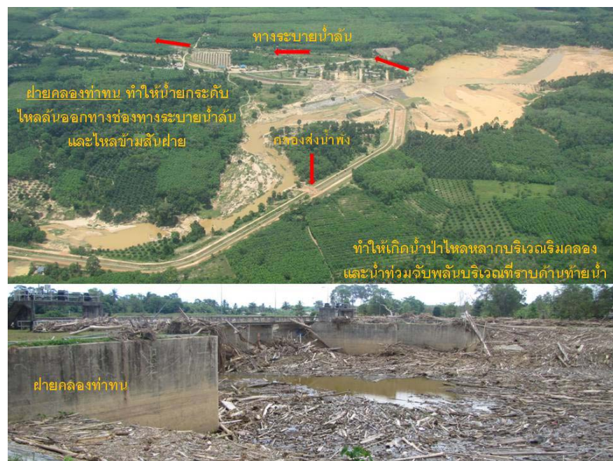
รูปที่ 5.2 ฝายคลองทำทอนที่สร้างกีดขวางทางน้ำ
