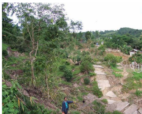
รูปที่ 2.5 ถนนคอนกรีตบนเชิงเขาที่ถูกตัดขาด
