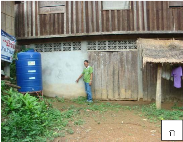
รูปที่ 3.31 ก) รอยคราบแสดงระดับน้ำท่วมบ้านเรือนริมห้วยน้ำป่าด ข)บ้านสบปิ่น บ้านเสี่ยงภัย น้ำป่าไหลหลากจากห้วยปิ่น หมู่ 4 บ้านปิ่น
