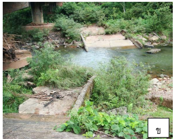
รูปที่ 3.2 หลักฐานการเกิดน้ำป่าไหลหลาก ก) ก้อนหินขนาดใหญ่ในพื้นที่นา ริมลำน้ำมาง ข) สะพานข้ามลำน้ำมางเดิมที่ถูกกระแสน้ำป่าไหลหลากพัดทำลายเสียหาย
