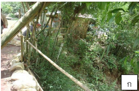
รูปที่ 3.13 บ้านเสี่ยงภัยดินไหลหมู่บ้านสว่าใต้ ก) หลังบ้านเป็นตลิ่งสูงชัน มีการกัดเซาะฐานด้านล่างโดยลำน้ำจอน ข) พื้นดินมีการปริแยกเป็นแนวยาว
