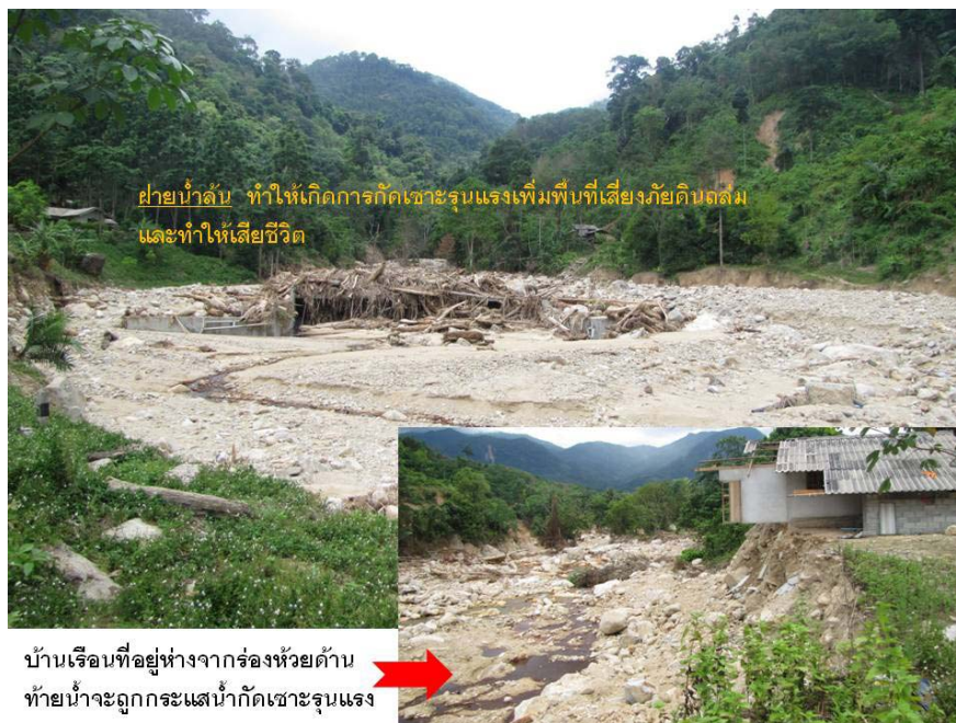
รูปที่ 5.1 ฝายน้ำล้นกีดขวางทางน้ำ
