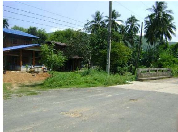
รูปที่ 3.27 บ้านเรือนในพื้นที่หมู่ที่ 7 บ้านผาลาด ตั้งอยู่ชิดติดลำห้วยทำให้เสี่ยงภัย น้ำป่าไหลหลาก
