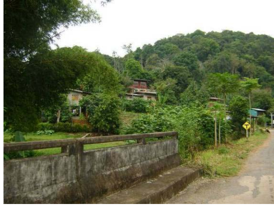
รูปที่ 3.34 บ้านเรือนในพื้นที่หมู่ที่ 10 บ้านปางตันผึ้ง ตั้งอยู่ชิดติดลำห้วย เสี่ยงภัยจากดินถล่มและน้ำป่าไหลหลาก
