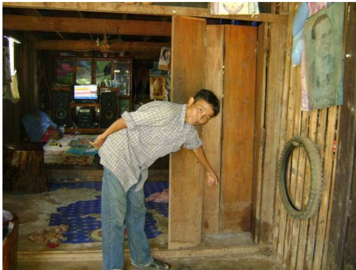
รูปที่ 3.20 ร่องรอยน้ำป่าไหลหลากในพื้นที่ หมู่ที่ 1 บ้านงอมถ้ำ เมื่อปี พ.ศ. 2549
