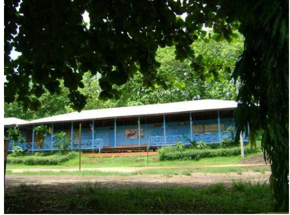
รูปที่ 3.24 พื้นที่ปลอดภัย หมู่ที่ 2 บริเวณโรงเรียน บ้านจอมมด
