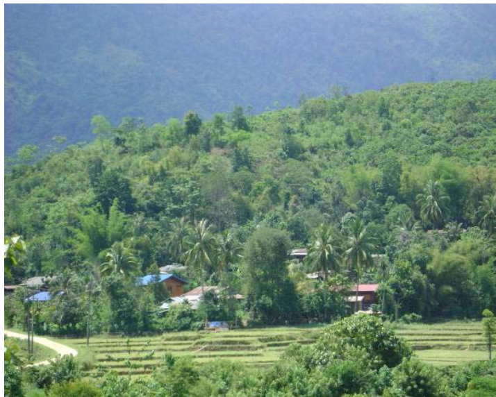
รูปที่ 3.3 ลักษณะบ้านเรือนในพื้นที่เสี่ยงภัยดินถล่ม ในพื้นที่ตำบลนางพญา ตั้งอยู่บนลาดเขา และมีร่องรอยดินถล่มในอดีต
