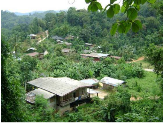
รูปที่ 3.33 บ้านเรือนในพื้นที่ หมู่ที่ 7 บ้านไฮฮ้า เสี่ยงภัยดินถล่ม เนื่องจากตั้งอยู่บนพื้นที่ลาดเขา มีร่องรอยดินถล่ม
