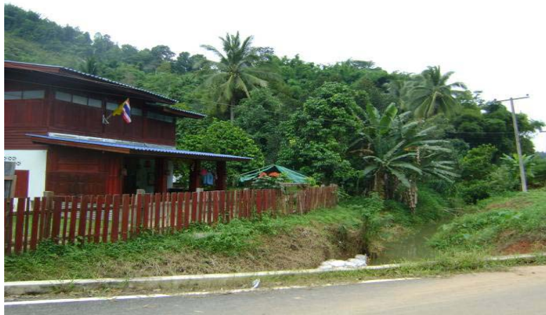
รูปที่ 3.35 บ้านเรือนในพื้นที่ หมู่ที่ 10 บ้านปางตันผึ้ง ตั้งอยู่ใกล้ลาดเขา ลำห้วย และหัวสะพาน เสี่ยงภัยจากดินถล่มและน้ำป่าไหลหลาก
