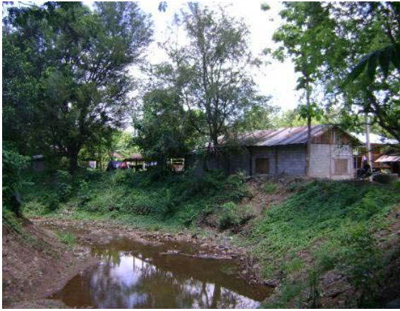
รูปที่ 3.18 บ้านเรือนในพื้นที่ หมู่ที่ 1 บ้านงอมถ้ำ ตั้งอยู่ชิดติดลำห้วยงอมถ้ำเสี่ยงภัยจากน้ำป่าไหลหลาก
